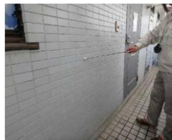
「外部（外壁）」調査の様子
