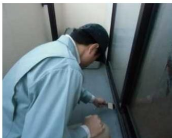
「外部（バルコニー）」調査の様子
