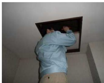
「小屋組・梁」調査の様子
