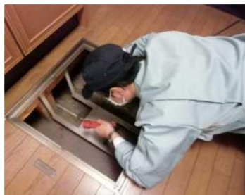
「土台・床組、基礎」調査の様子
