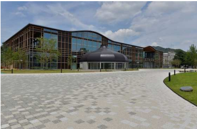
みんなの森ぎふメディアコスモス 外観
