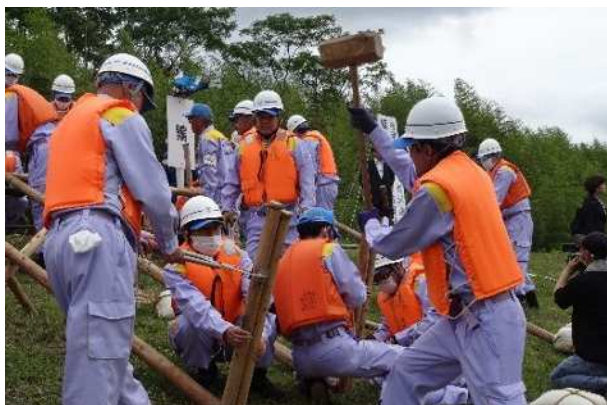
杭打積土のう工
