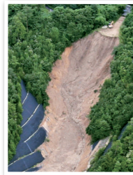
廃棄された土石の崩落により 死者1名、重傷者1名 住宅被害1棟
