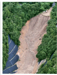
廃棄された土砂の崩落により 死者1名、重傷者1名 住宅被害1棟
