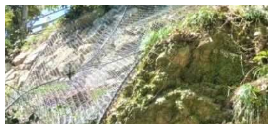
写真_6 石垣(遺構)の保護
