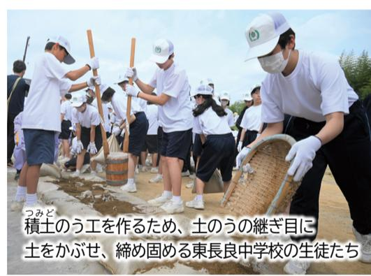
つみど 積土のう工を作るため、土のうの継ぎ目に土をかぶせ、締め固める東長良中学校の生徒たち
