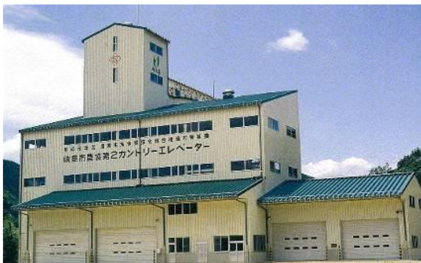
ぎふ農業協同組合第 2 カントリーエレベーター
