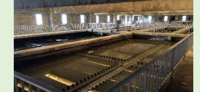
供用開始から50年以上が経過した水処理施設
