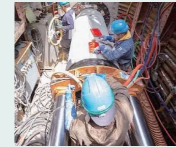
中部幹線バイパス管工事
