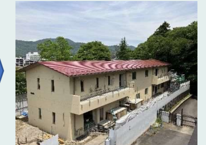
建設中の新管理棟 令和6年完成予定
