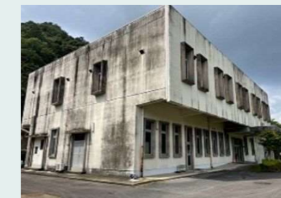
現在の管理棟 昭和48年竣工 (築50年)
