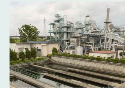
北部プラント 昭和41年供用開始 (築57年)
