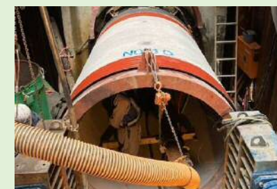
【幹線管渠の耐震化工事】
