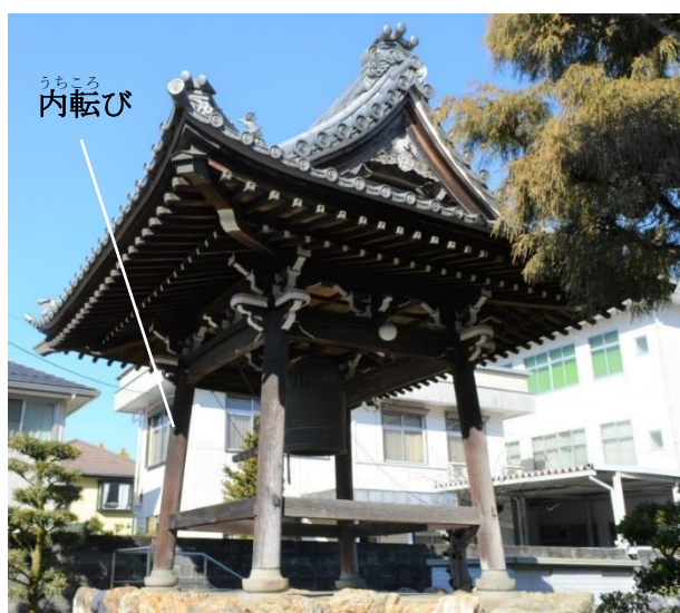
鐘楼外観（南東より）
