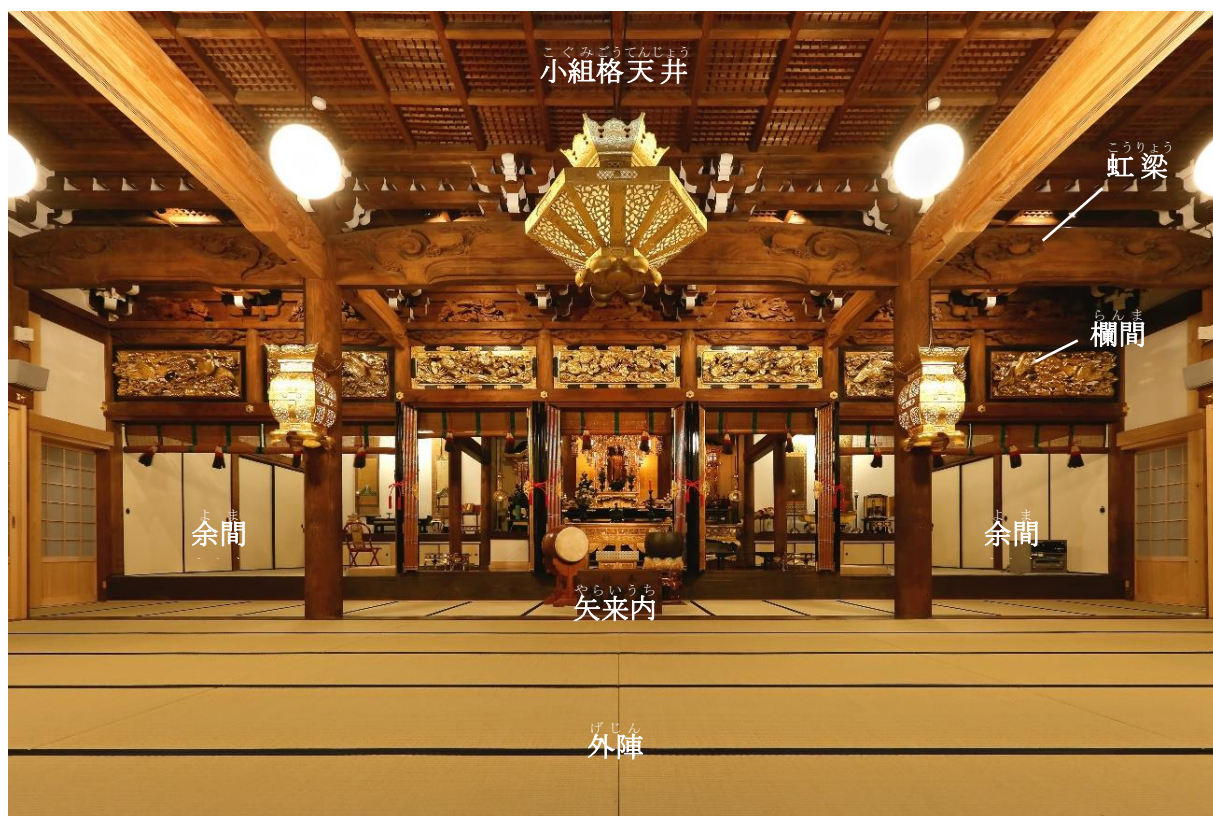
本堂内部全景（外陣南より）
