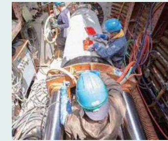
中部幹線バイパス管工事
