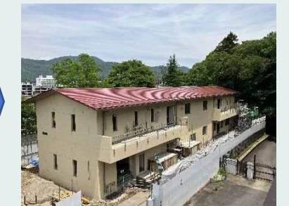
建設中の新管理棟 令和6年完成予定
