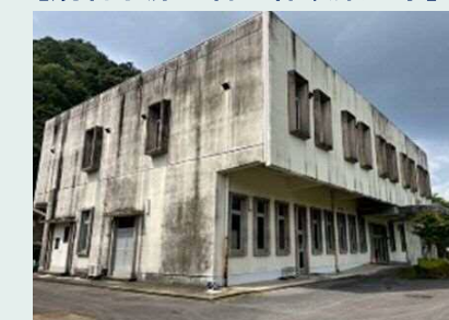
現在の管理棟 昭和48年竣工 (築50年)
