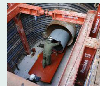
金華地区配水幹線布設替工事
