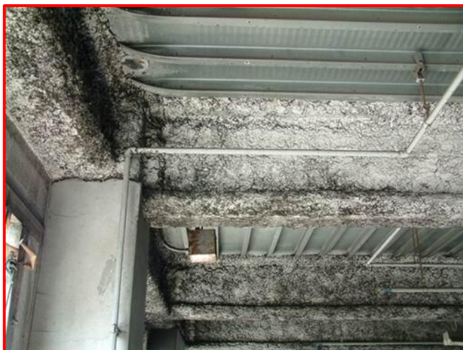
②石綿含有吹付けロックウール
