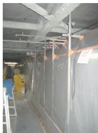
図 4.7.6 同上施工区画 (内部側、右外側が車路)
