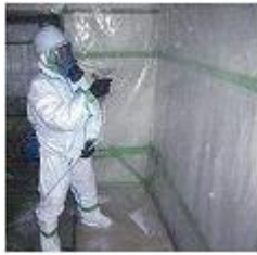
②隔離シートへの散布
