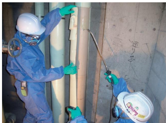
図 4.8.3 保温材の湿潤化→取り外し
