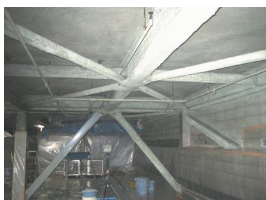
図 4.7.5 同上施工区画の内部側
