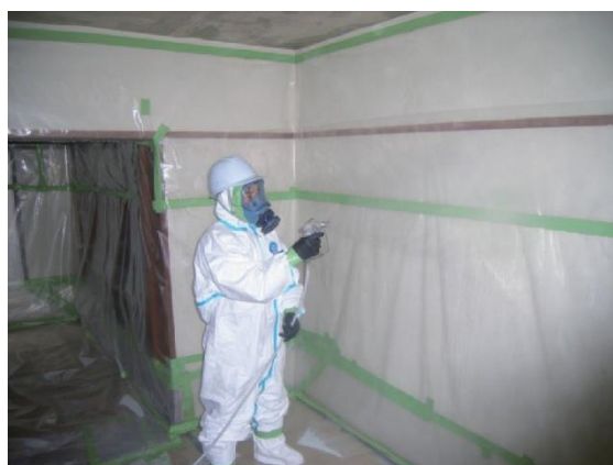
図 4.7.79 隔離シートへの粉じん飛散防止処理剤の散布
