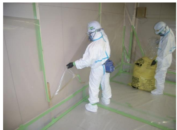
図 4.7.91 隔離シートの撤去
