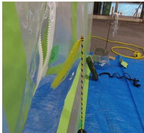
図 4.14.11 吹き流しによる確認
