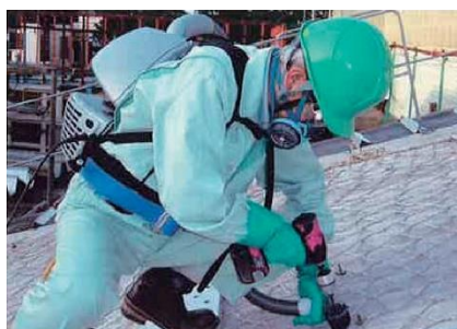
粉じん回収（高性能真空掃除機）
