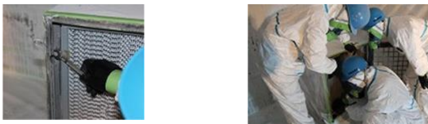
図 4.7.84 HEPAフィルタの留め付の緩み点検
