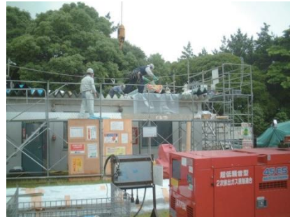
図 4.10.17 折板をはがしているところ
