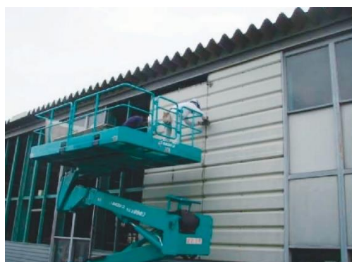
壁金物取外し
