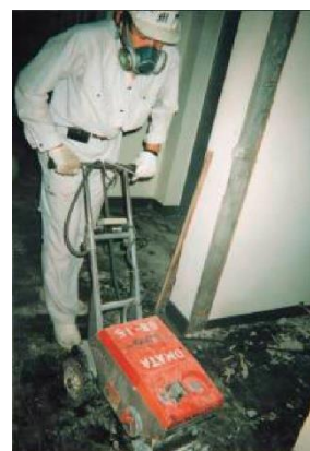
図4.11.12 石綿含有ビニル床タイルの 除去例
