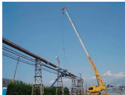
図 4.10.5 配管の吊り下ろし
