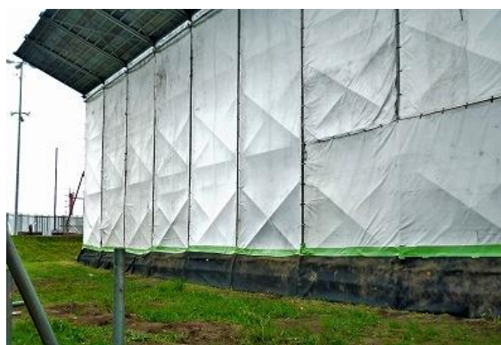
周囲への飛沫飛散防止養生例（外部）
