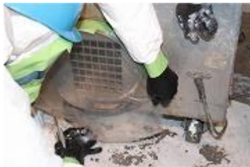
集じん・排気装置の排気口をプラスチックシート等で封鎖
