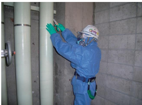
図 4.8.2 保温材被覆撤去
