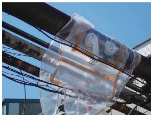
図 4.10.3 切断箇所へのグローブバッグ取付
