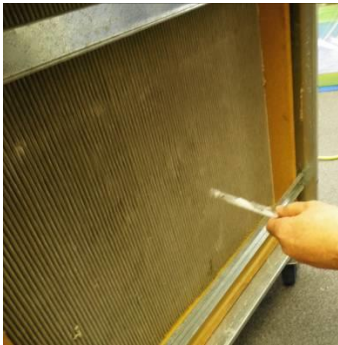
図 4.7.48 HEPA フィルタ面
