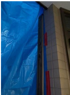
③外壁とシートを角材で固定。シートの反対側は足場のシート等と繋ぐ。
