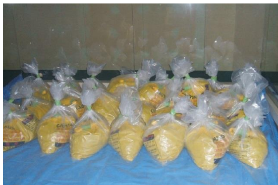
図 4.7.78 除去した石綿廃棄物の保管
