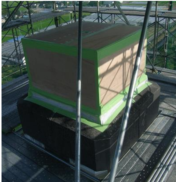
図 4.7.34 煙突開口部養生例
