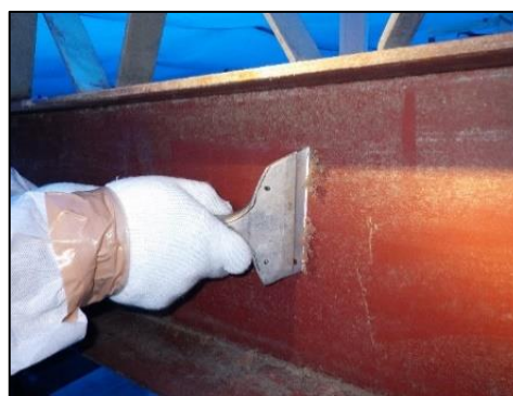
図4.15.5 再付着した石綿の除去
