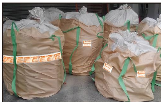
図4.11.22 石綿含有廃棄物の保管例
