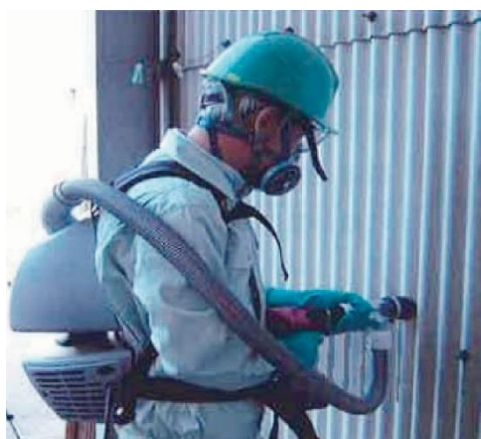
図4.11.7 機械工具による切断例
