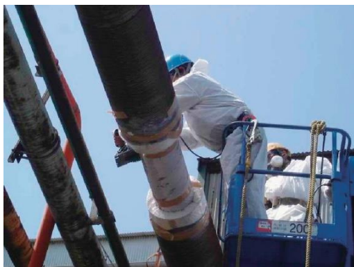
図 4.10.4 切断箇所の保温材除去と養生
