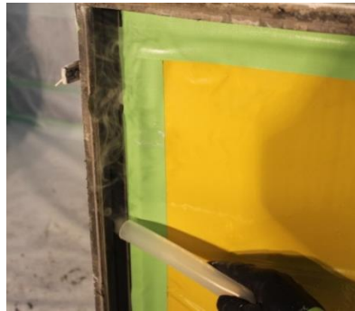
図 4.7.49 HEPA フィルタ 周辺部分
