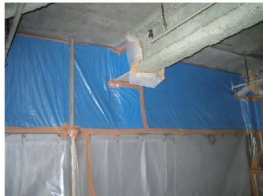
図 4.7.12 壁面の負圧隔離養生例 (作業場内側)
