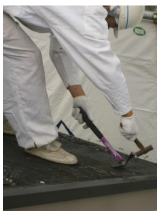
固定部分の取外し※
