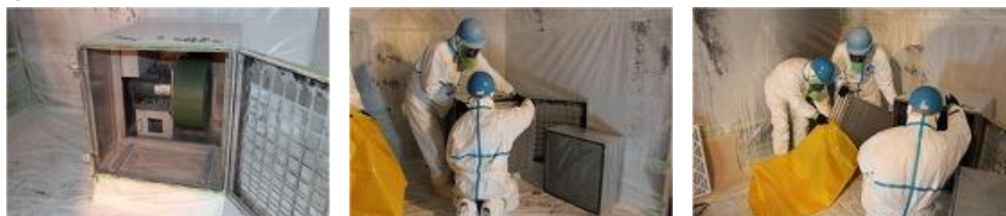
図 4.7.85 HEPAフィルタの交換
