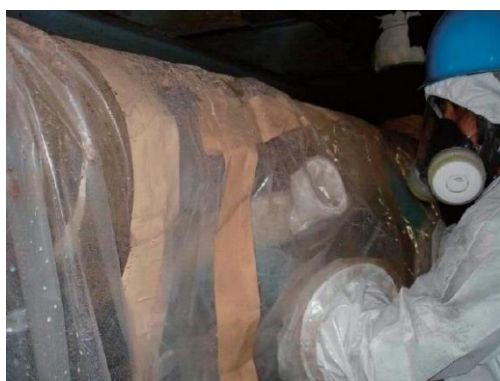
図 4.10.10 石綿除去作業中 2
