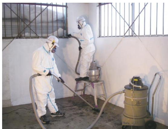
図 4.7.92 高性能真空掃除機を用いた作業場内の仕上清掃
