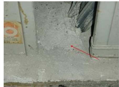
(参考資料) 写真6-6 電気配線部分 隙間閉鎖
