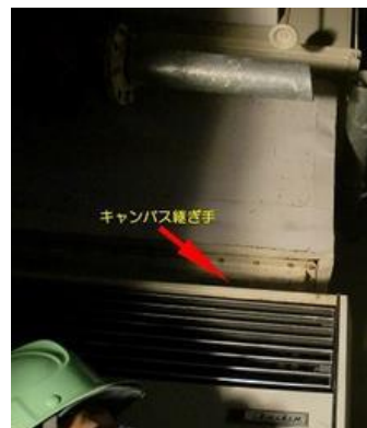
（参考資料）写真6-11 キャンバス継ぎ手
