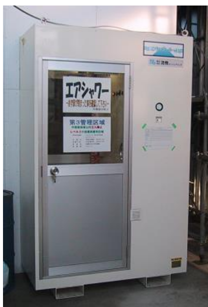
写真Ⅲ-4 エアシャワールーム(2重扉)の例
