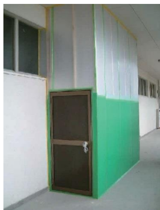
図 4.7.7 教室前廊下の施工区画 (外部側)
