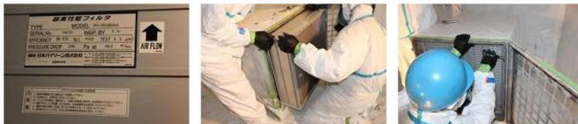
図 4.7.86 フィルタの取り付け
