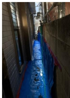
⑤床部シート養生の設置（通気性がない素材）※奥や手前の端も確実に囲う。
