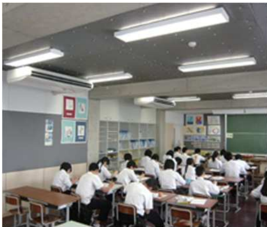
教室空調施設整備（エアコン）
