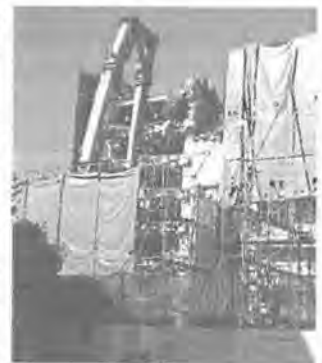
現在解体工事が進む岐阜市役所旧庁舎
