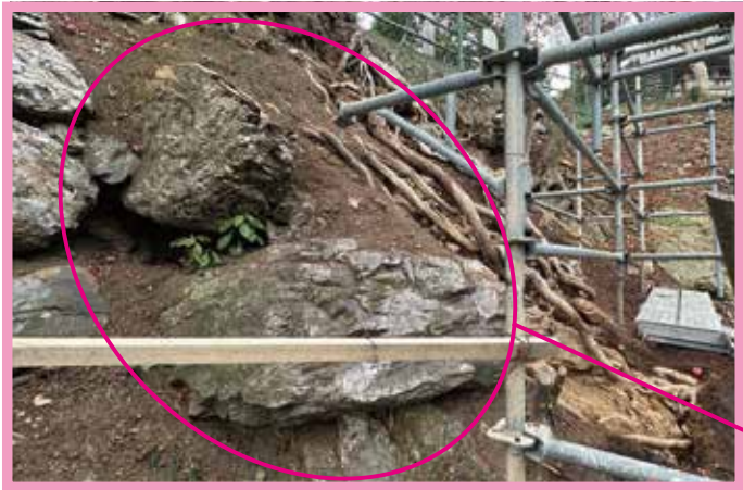
確認した巨石石垣（北から）
