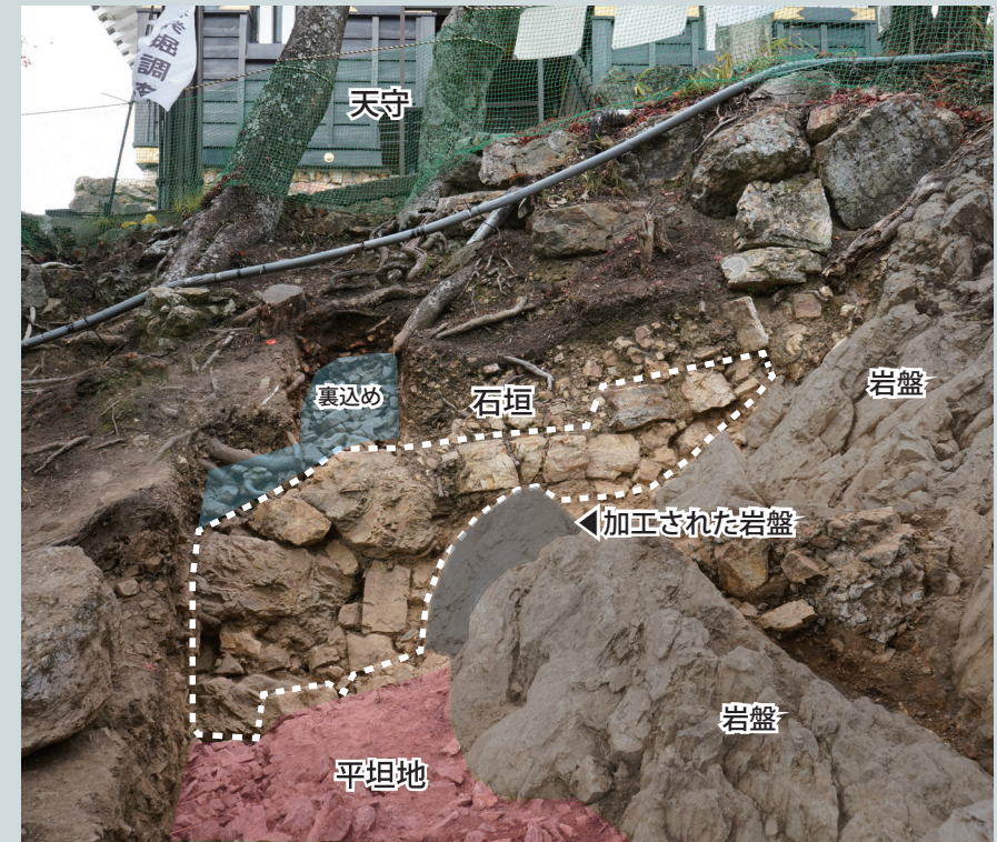
石垣と石垣前面の平坦地
