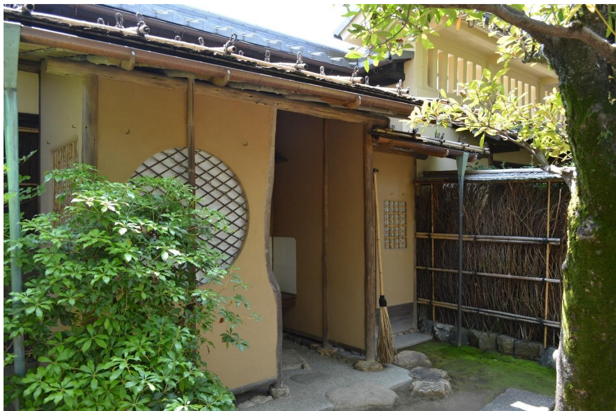
待合外観（北西より望む）
