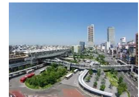
岐阜駅北口駅前広場
