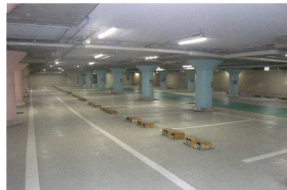
岐阜市金公園地下駐車場
