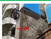
附属部材(※)の腐食、破損 ※鉄釘、止め棒、角ばり、その他附属品
