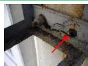
アンカーボルト・取付部プレートの腐食、変形
