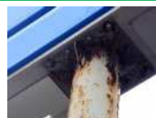
鉄骨接合部（溶接部・プレート）の腐食、変形、隙間
