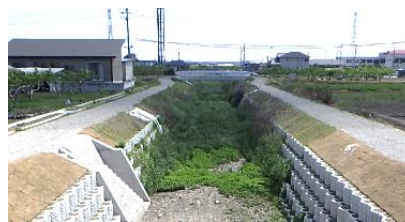
西出川での多自然川づくりの様子
