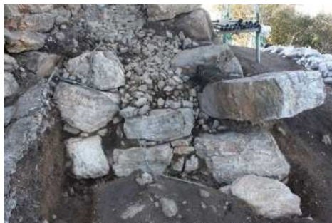
⑤天守台北西隅の石垣(令和元年度)
