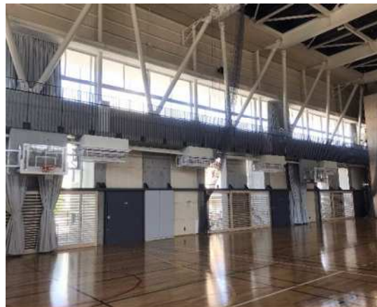
体育館空調設備整備（エアコン）
