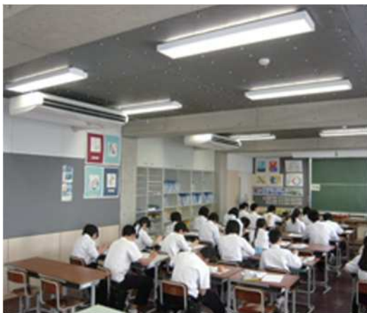
教室空調施設整備（エアコン）
