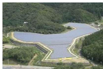
DREAM★Solar ぎふ太陽光発電所 (三輪北地区：市最終処分場跡地)
