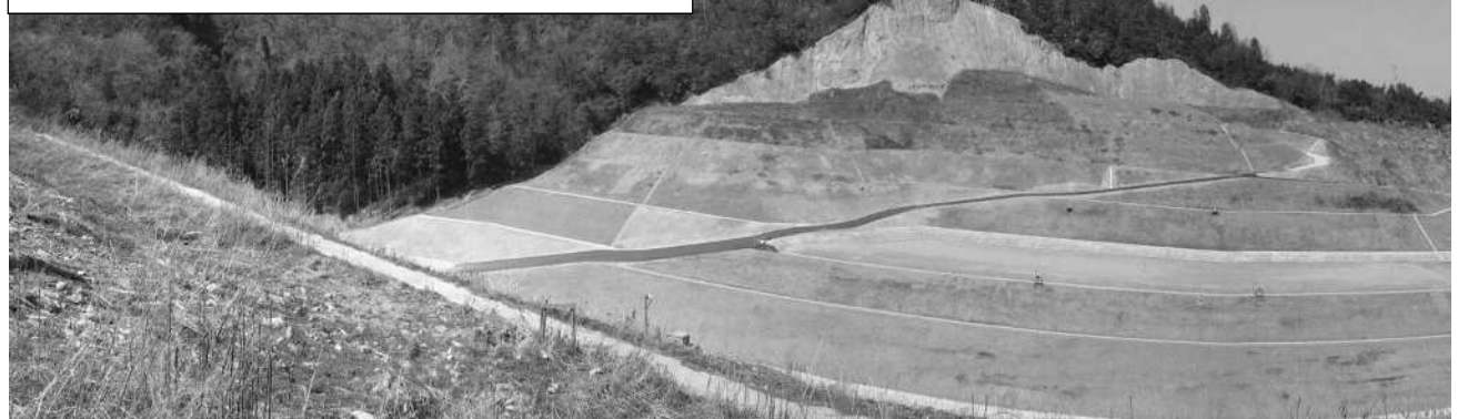
工事完了後の最上部の状況(平成 25 年 3 月撮影)
