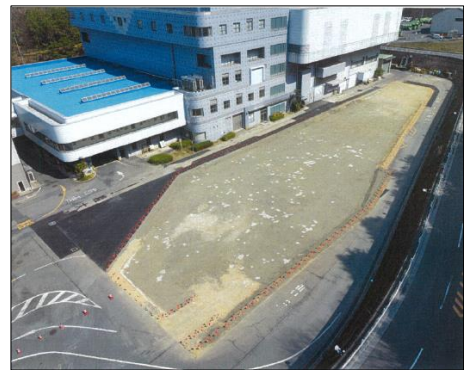
旧粗大ごみ処理施設 解体後の状況
