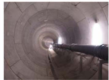
梶川町貯留槽(2014年完成)
