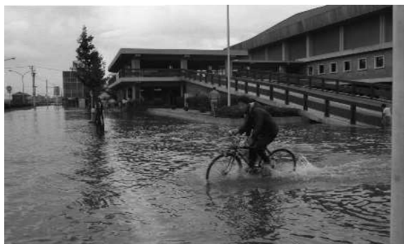
県庁付近の湛水の様子
