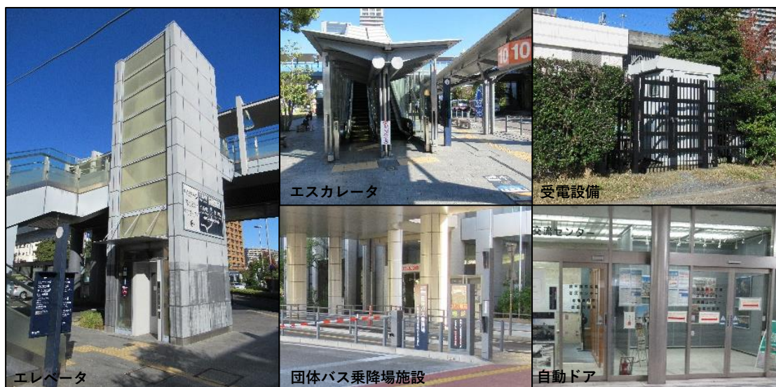
写真4 機械設備の設置状況
