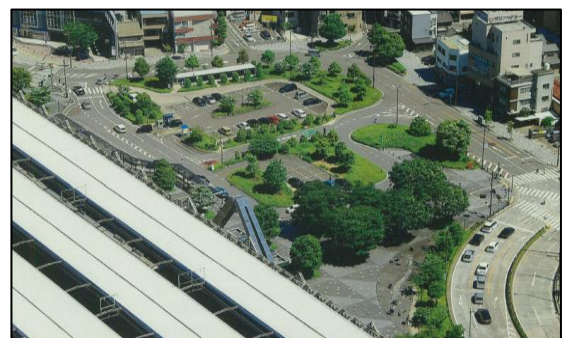
写真2 岐阜駅南口駅前広場
