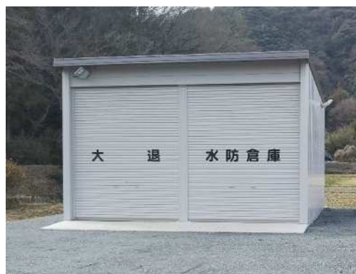
倉庫製品(軽量鉄骨造)(大退水防倉庫)
