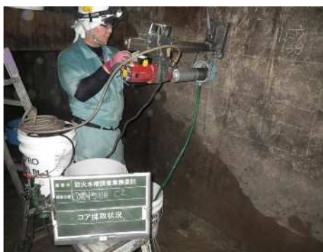
コンクリートコア採取状況
