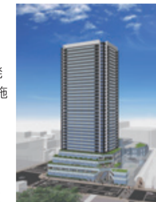
▲令和4年度に竣工予定の高島屋南地区「柳ヶ瀬グラスル35」
