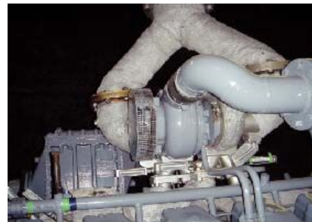
配管エルボの保温材②
