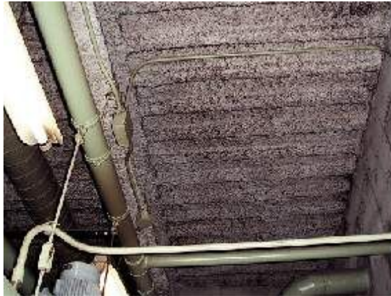
天井断熱材 天井、壁吸音材
