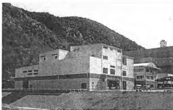
完成した粗大ごみ処理施設全景(西から東を望む)
