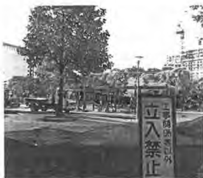
リニューアル工事の金公園
