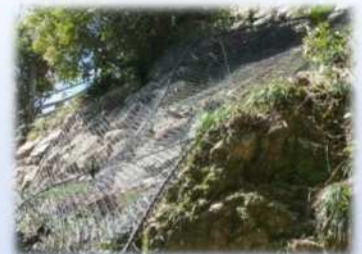
石垣の落石防止網設置
