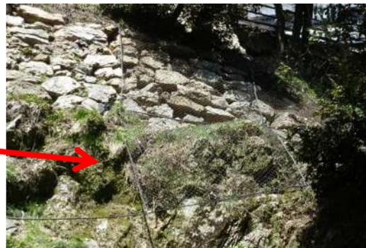
写真 3-26 天守南西部石垣落石防止網設置状況（部分）
