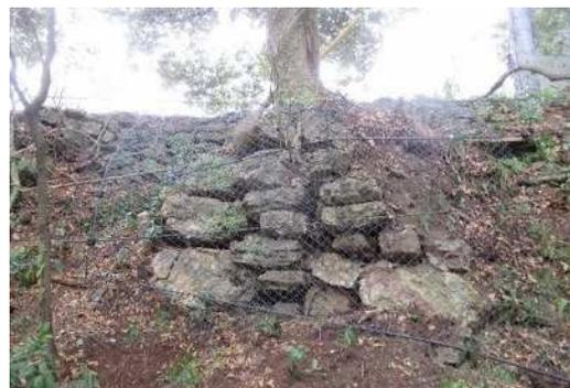
写真 3-28 上台所南側石垣落石防止網設置状況
