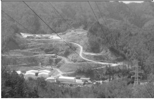
掘削開始直後の現地の様子(平成 22 年 3 月撮影)
