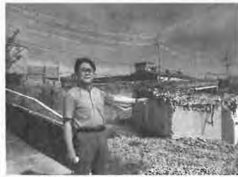
衛生施設組合の解体現場をみる井深正美市議
