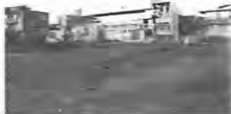
長良小プール・公民館建設予定地(校舎西) 12月18日現在
