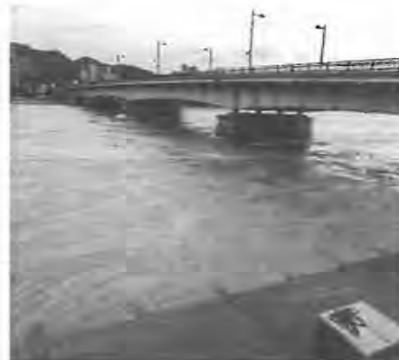
7月8日、午前、長良橋南、大宮陸橋が閉鎖された長良川の状況
