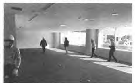
各部屋も着々と完成へ 内装完成を待つばかりです
