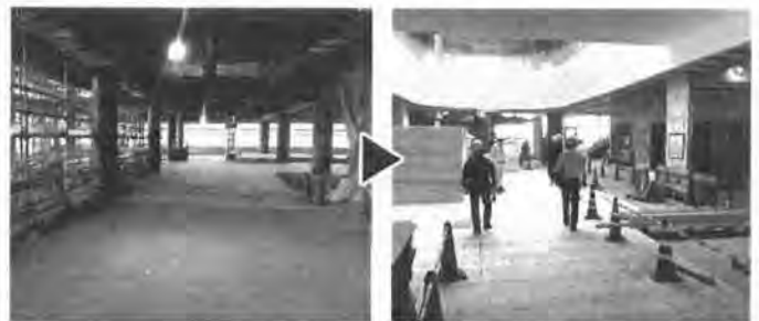
2階の内装工事も終盤になってきています
