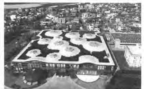
上層階から見た北側風景 メディアコスモスの屋根
