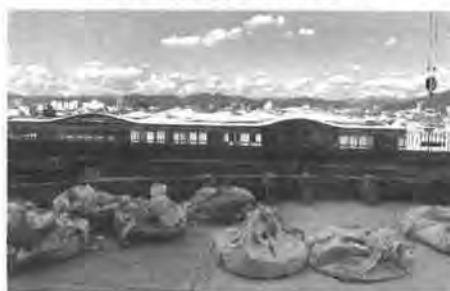
4階北側野外の庭園 憩いの場へと最後の仕上げ
