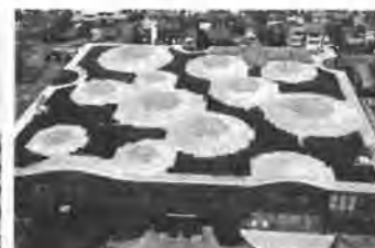
庁舎北側にはメディアコスモス
