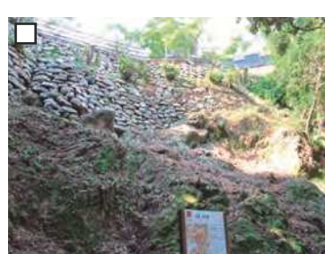
⑥ 上台所と天守の間に2段に築かれた石垣です。信長期以降に谷であった場所に平坦な通路を造るため築かれたと考えられます。
