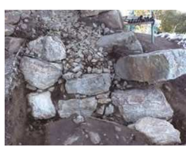
⑦ 現在の天守北西角から戦国期の天守台石垣が見つかりました。積み方の特徴や見つかった遺物から信長期に築かれたと考えられます。 ※立ち入り禁止です。
