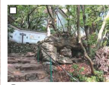
⑤ 二ノ門の入口に築かれた石垣です。角の部分は非常に大きな石材を用いて積み上げられています。
