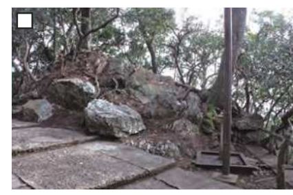
① 一ノ門に築かれた石垣です。岩盤の周囲に、石垣と巨石石垣を組み合わせてコーナー部分を造り出しています。構造や平面形が山県市にある16世紀前半に土岐氏によって築かれた大桑城の「岩門」と類似することから、後斎藤期に築かれたと考えられます。
