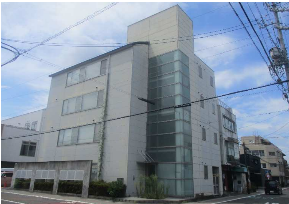
現地写真(南東から撮影)
