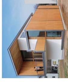
CLT工法による実験棟
