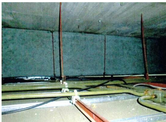
コテで押さえ、「囲い込み」されたアスベスト (高層部 4 階 4-1 会議室)
