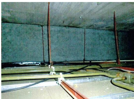
コテで押さえ、「囲い込み」されたアスベスト (高層部 4 階 4-1 会議室)
