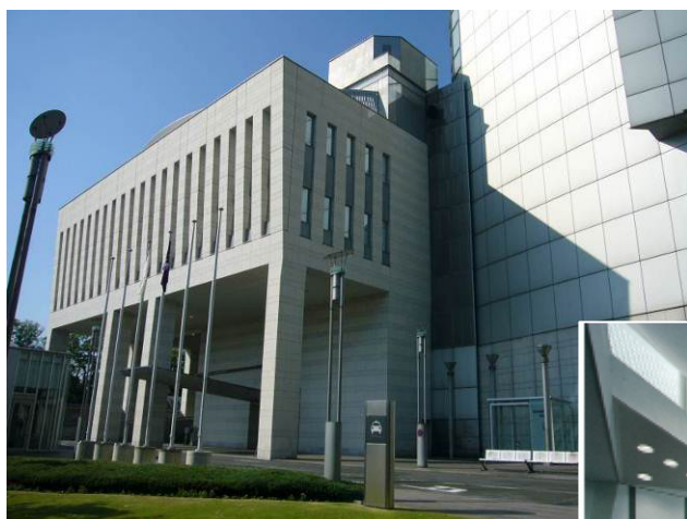
写真 議会棟及び議場
