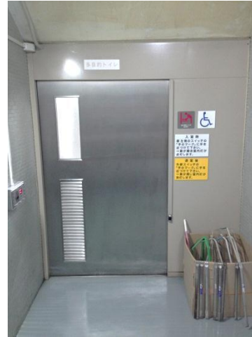
写真③ 南庁舎1階の多目的トイレ
